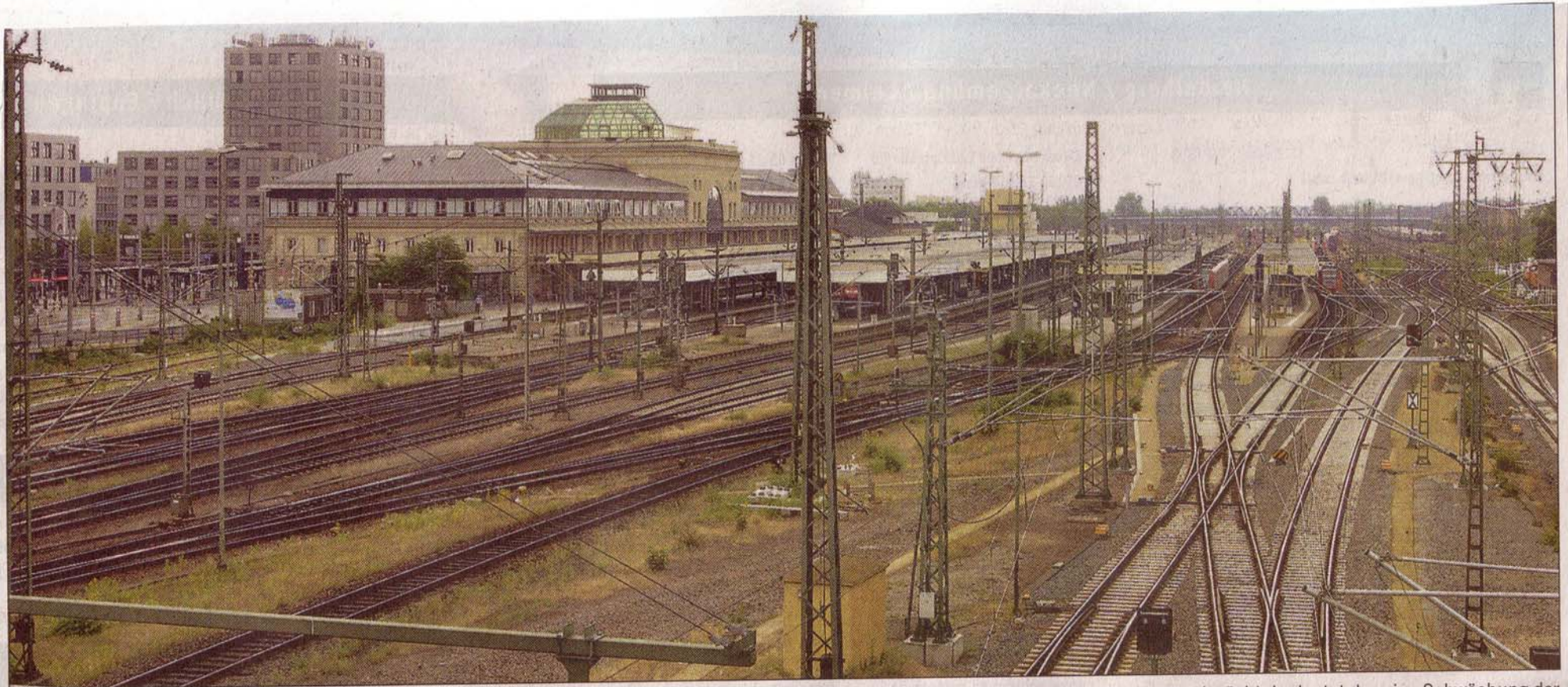
Der Hauptbahnhof Mannheim – hier die Rückseite – ist mit rund 72 000 Reisenden täglich der wichtigste Knoten Süddeutschlands. Wird er geschwächt, bedeutet das eine Schwächung der gesamten Metropolregion und hat negative Auswirkungen auf den Schienenverkehr in ganz Baden-Württemberg. Foto: vaf
